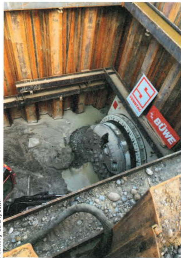
Abbildung: Berding Beton
