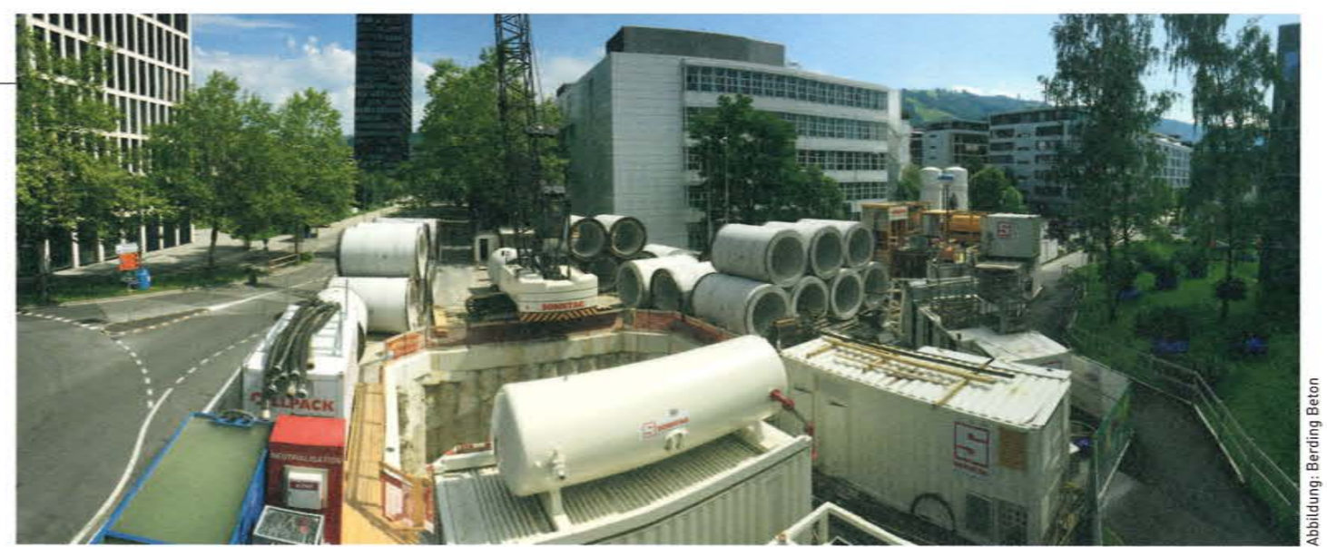
Der Blick auf die Baustelle in der Stadt Zug.
