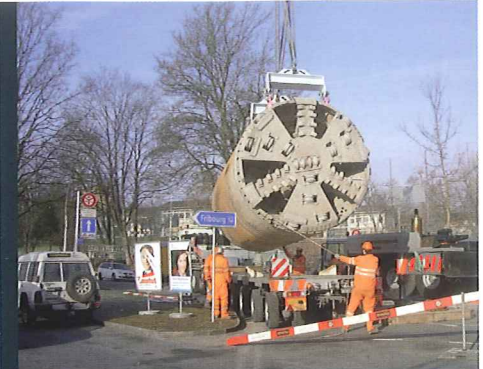
KVA Bern: Bergung der Microtunneling-Maschine nach erfolgreichem Durchstich.
