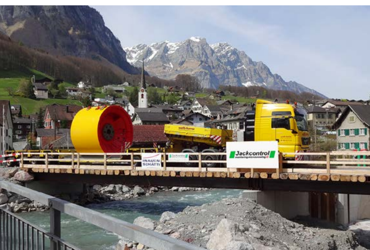
VORTRIEB KRAFTWERK DOPPELPOWER, SCHWANDEN (CH): HILFSBRÜCKE
