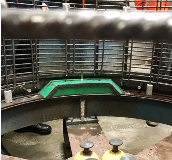
AUSSPARUNGSKÖRPER AUF MANSCHETTENTRÄGER/UNTERMUFFE
