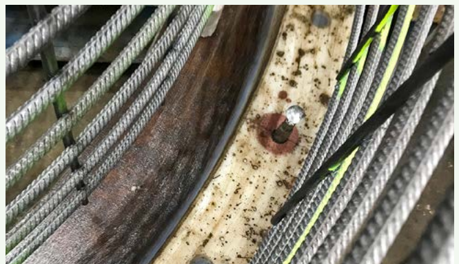
KONSTRUKTIVE DURCHBILDUNG VORTRIEBSDRUCKRINGS AUS STAHLBETON
