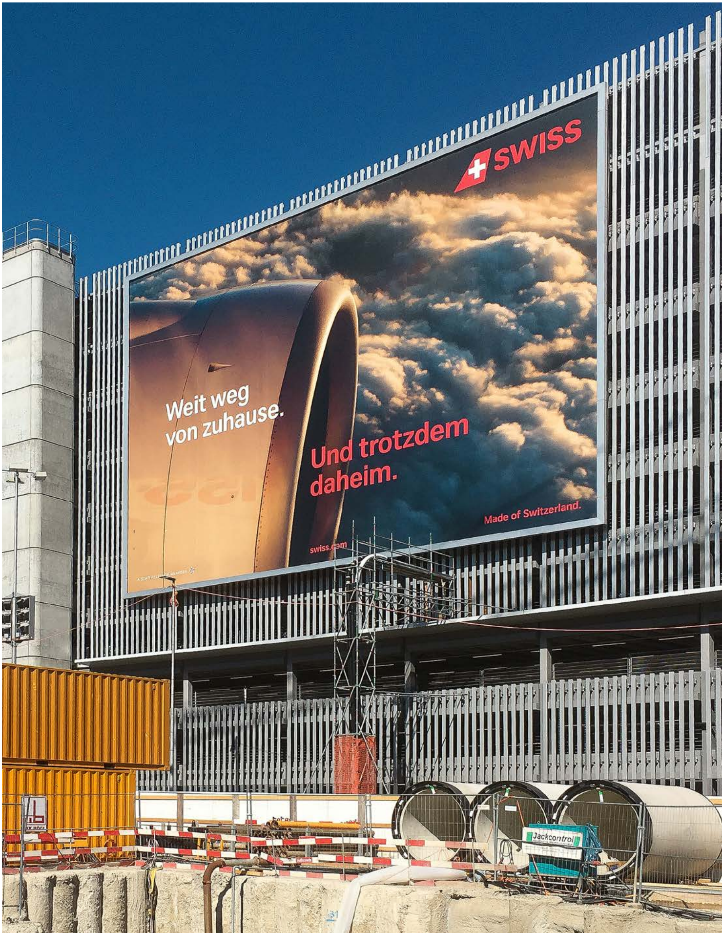
VORTRIEBSBAUSTELLE AM FLUGHAFEN IN ZÜRICH (CH)
