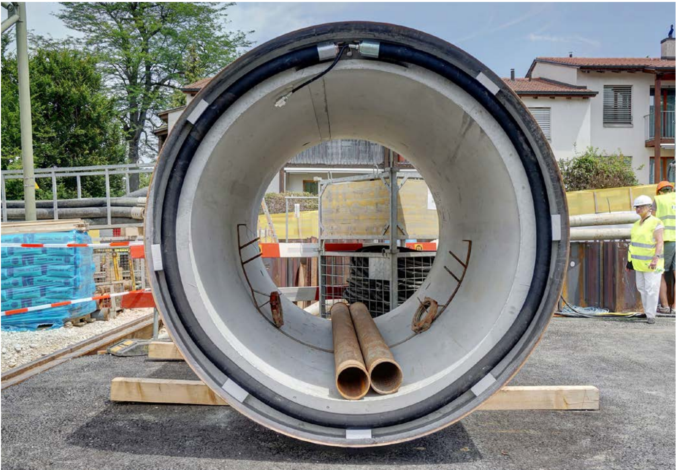
DIE HYDRAULISCHE FUGE MONTIERT
