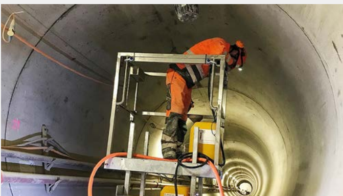
ZEMENTLEIMINJEKTION: MISCHER MIT ZEMENT IM STARTSCHACHT FÜR INJEKTIONEN STOLLENMOBIL IM VORTRIEB
