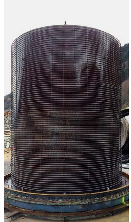
BEWEHRUNGSKORB IN SCHALUNG
