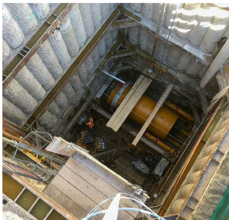
STARTSCHACHT IN BOHRPFÄHLWAND
