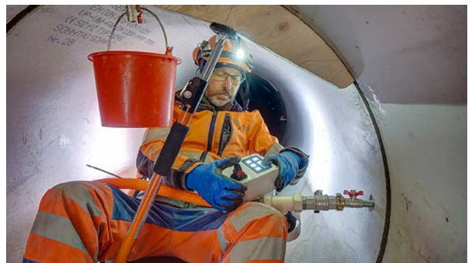
RINGRAUMVERFÜLLUNG JCGROUT MIT DEM CT ROVER
