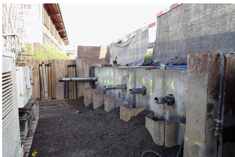
VORTRIEB HOCHWASSERSCHUTZ REICHENBURG (CH): ROHRSCHIRM
