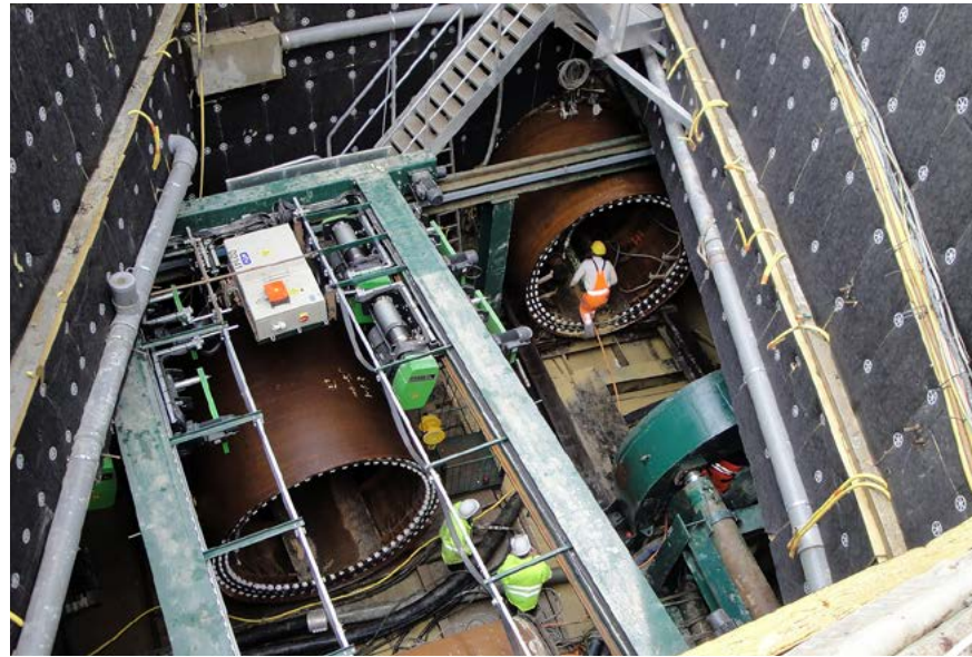
VORTRIEB TUNNEL SCHUMANN-JOSAPHAT, BRÜSSEL (BE): STAHLROHRE GEFLANSCHT
