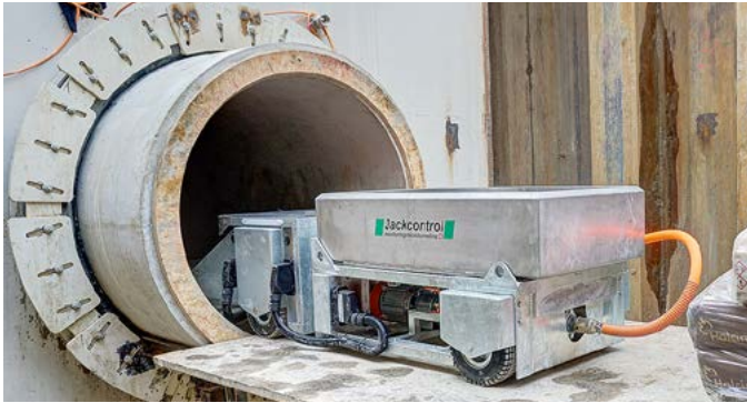
CT ROVER MIT ZEMENTWANNE/-MISCHER UND INJEKTIONSPUMPE AM TUNNELLEINGANG
