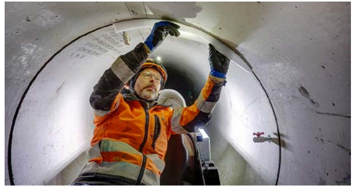
EINBRINGEN DES SCHALUNGSSTREIFENS IN DEN AUSSPARUNGSBEREICH IN ROHR DN 1200 MM
