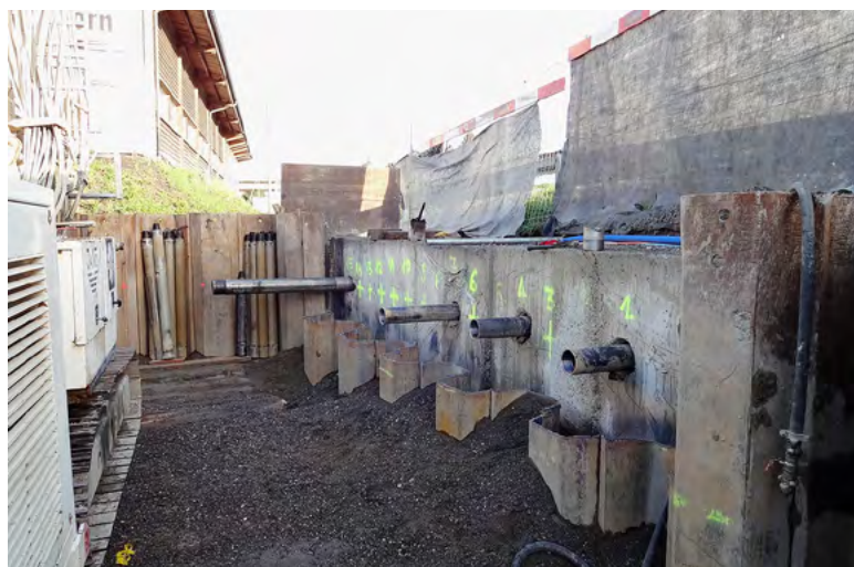
VORTRIEB HOCHWASSERSCHUTZ REICHENBURG (CH): ROHRSCHEM
