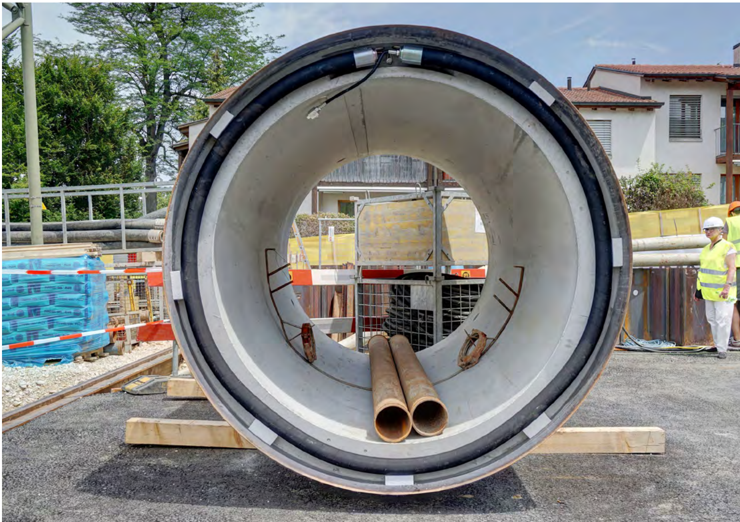
DIE HYDRAULISCHE FUGE MONTIERT
