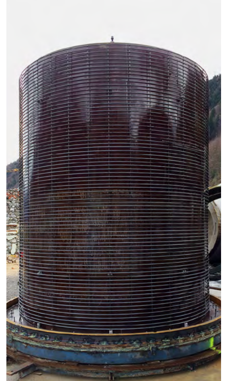
BEWEHRUNGSKORB IN SCHALUNG
