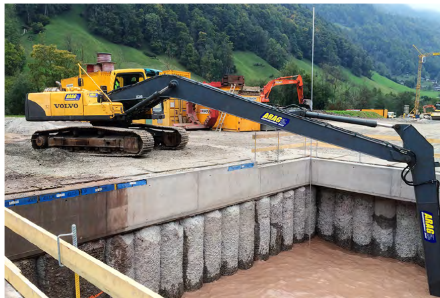
VORTRIEB WASSERKRAFTWERK RUFİ, HÄTZINGEN (CH): UNTERWASSERAUSHUB ZENTRALE UND STARTSCHACHT
