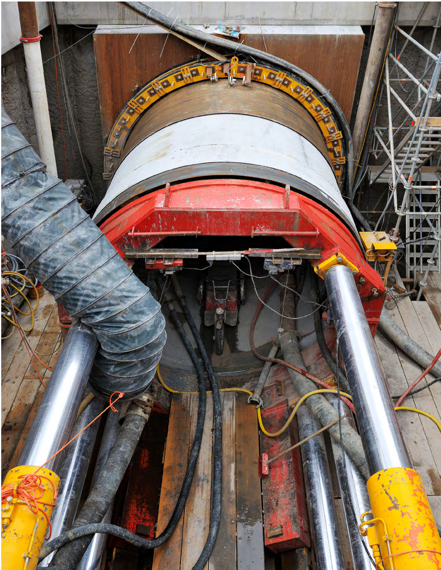
VORTRIEB WASSERKRAFTWERK RUF1, HÄTZINGEN (CH)
