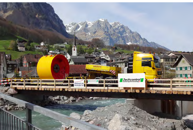
VORTRIEB KRAFTWERK DOPPELPOWER, SCHWANDEN (CH): HILFSBRÜCKE
