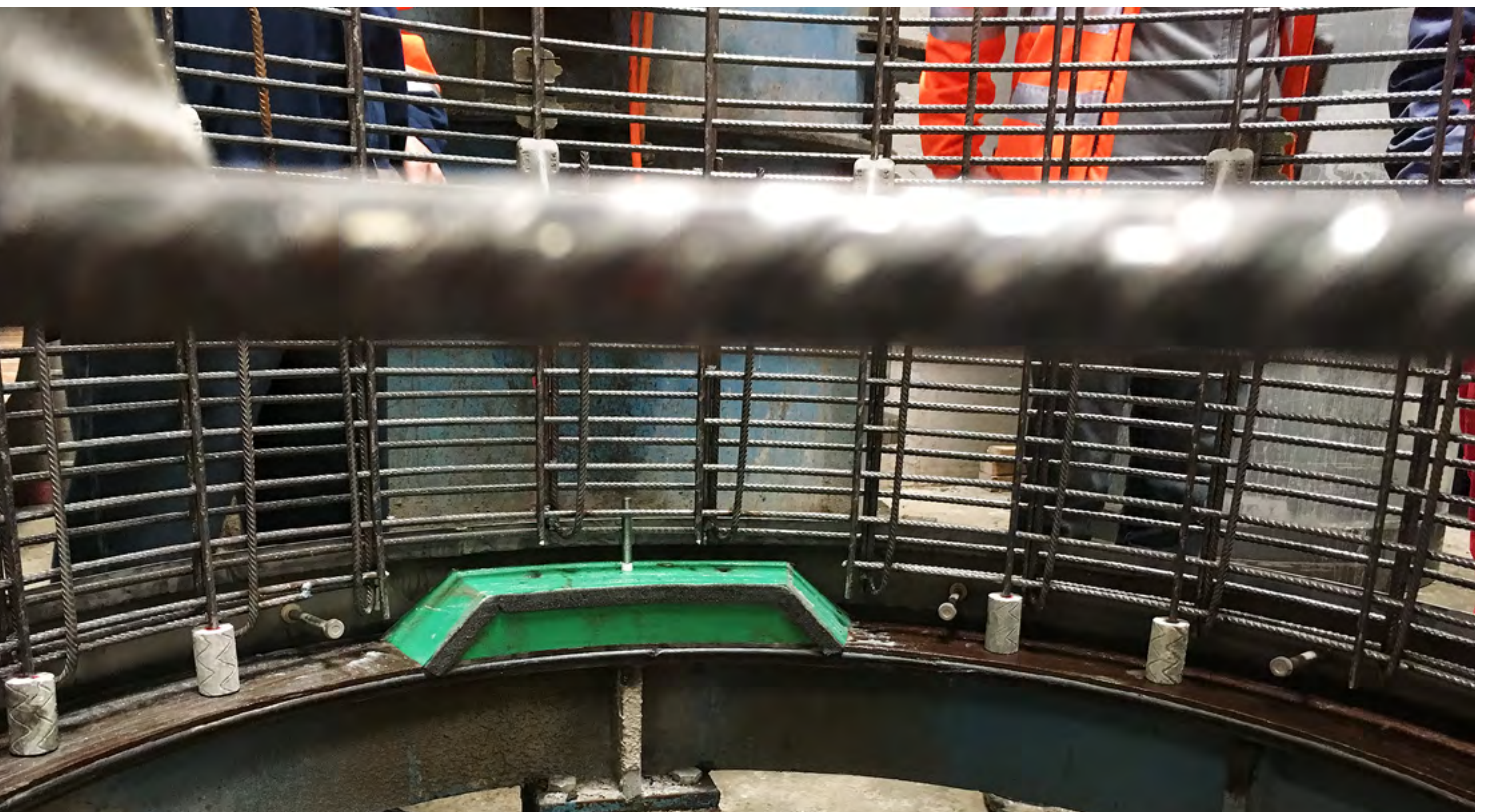
AUSSPARUNGSKÖRPER AUF MANSCHETTENTRÄGER/UNTERMUFFE
